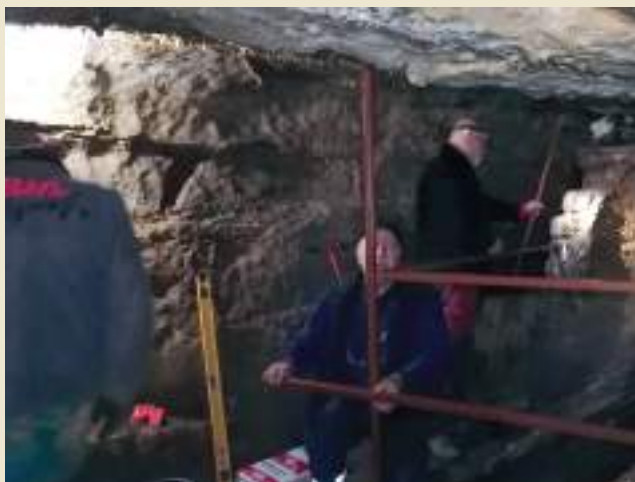
Figure 9. Montage de la balustrade.
