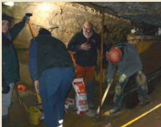
Figure 8. Installation de la barre verticale maitresse.
